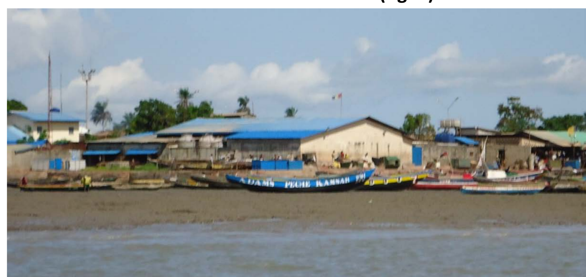
Fig. 4: Usine de conditionnement et d'expédition du poisson à Kamsar (Guinée), à 5 heures de pirogue de l'ACMP de Tristao
